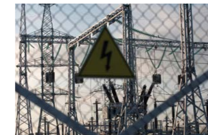
Реконструкция трансформаторной подстанции г. Севастополь
