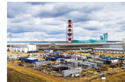
Богучанский алюминиевый завод Красноярский край
